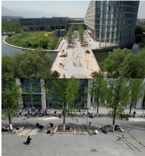
搭建现场照片
